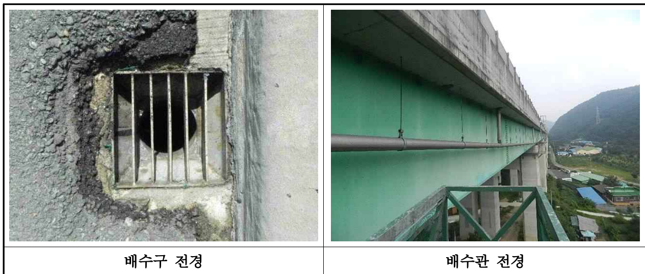
【사진 3.3.23】 배수구 및 배수관 전경(부산)
