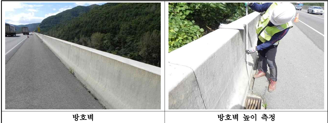
【사진 3.3.25】 난간 및 연석 전경(부산)
