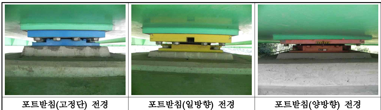
【사진 3.3.14】 교량받침 전경(부산)
