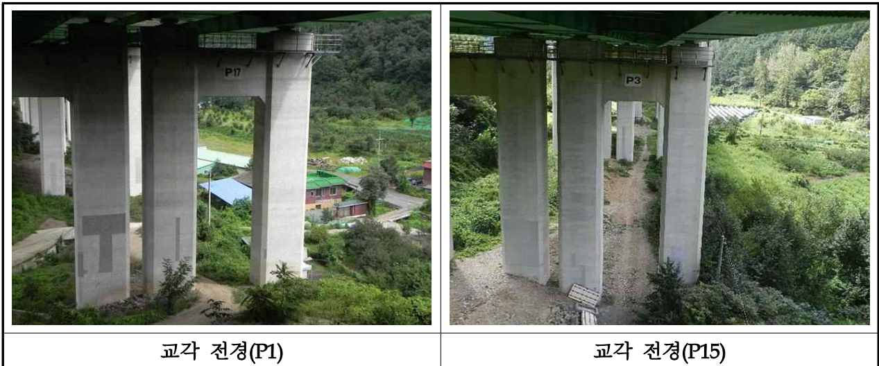
【사진 3.3.10】 교각 전경(부산)
