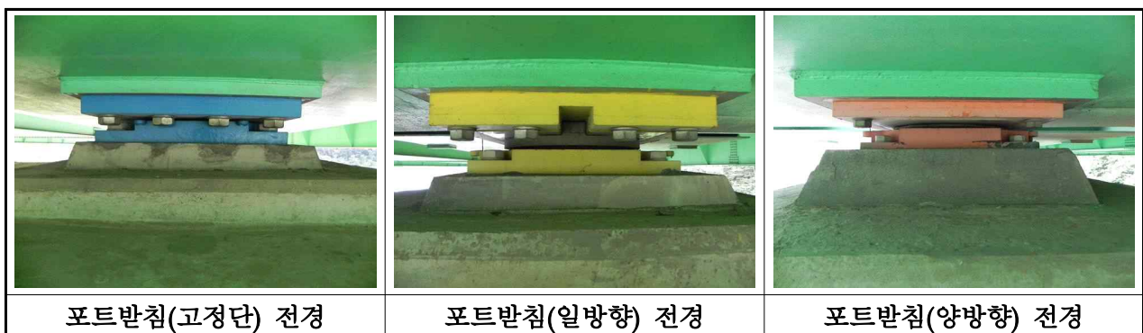
【사진 3.2.13】 교량받침 전경(대구)
