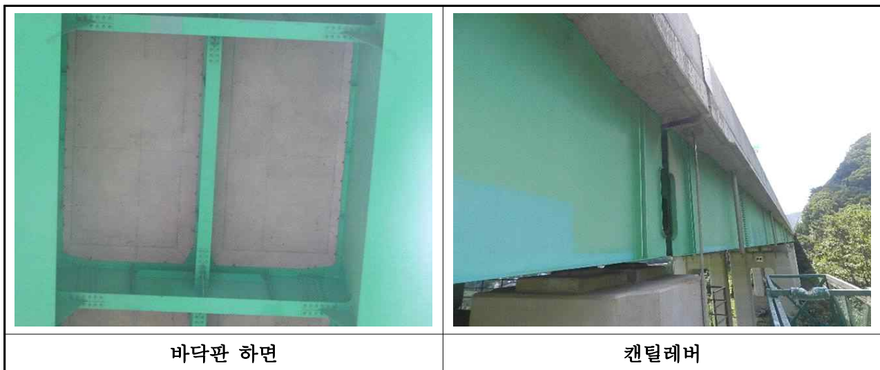
【사진 3.2.1】 바닥판 전경(대구)
