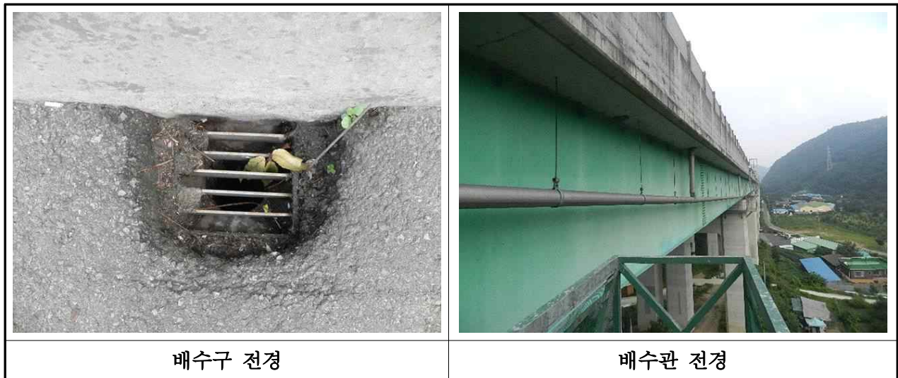
【사진 3.2.22】 배수구 및 배수관 전경(대구)
