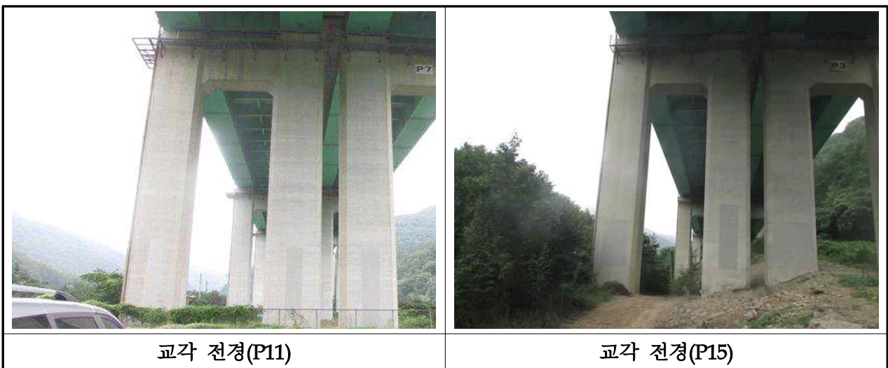
【사진 3.2.9】 교각 전경(대구)
