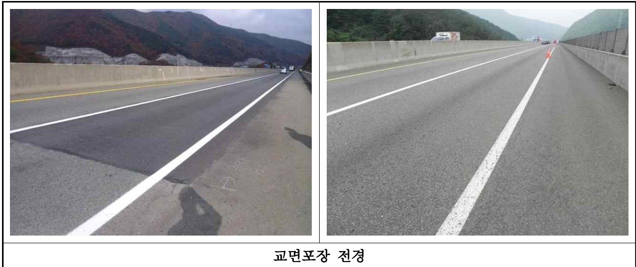
【사진 3.2.20】 교면포장 전경(대구)
