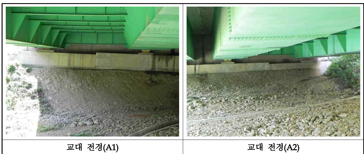
【사진 3.2.7】 교대 전경(대구)
