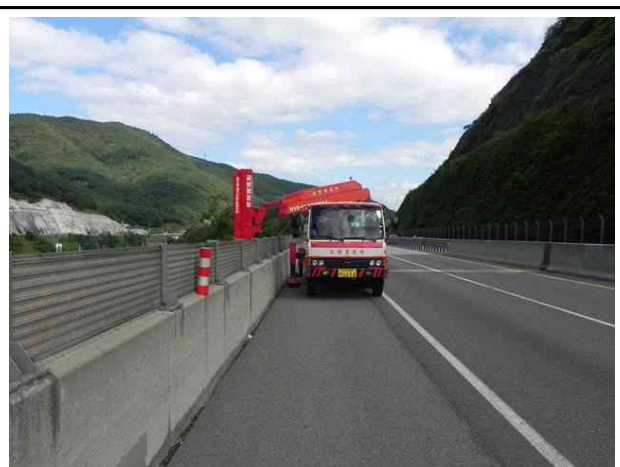
교량점검차를 이용한 조사
