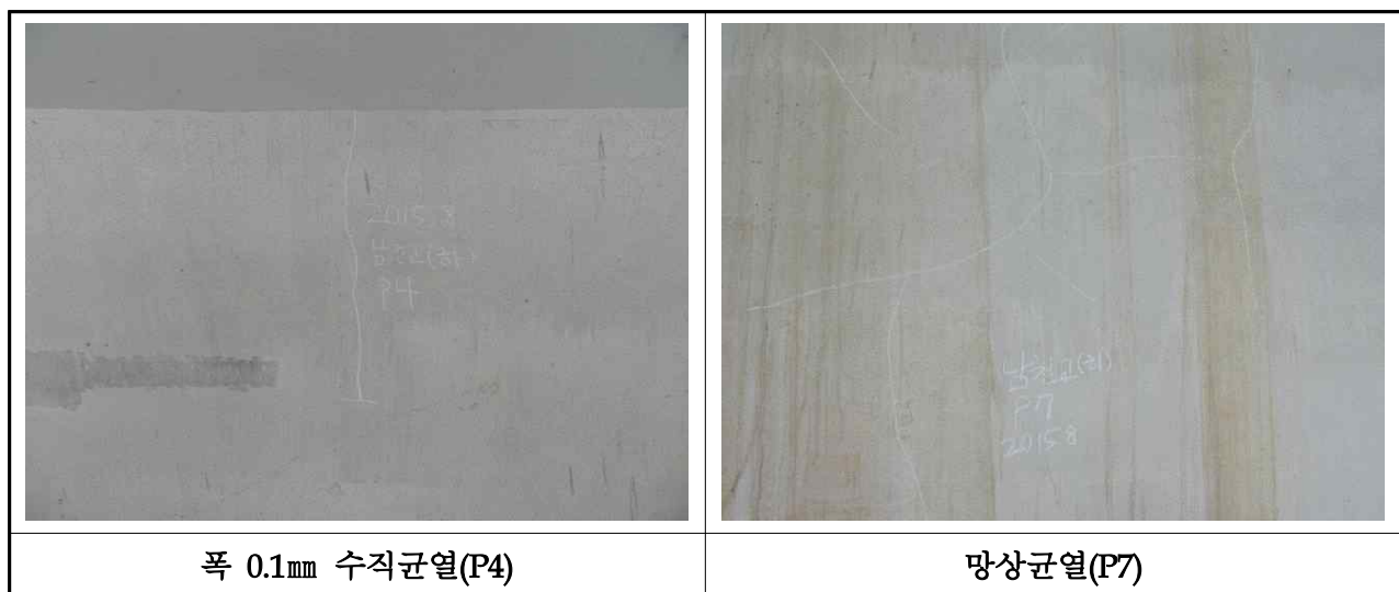
【사진 3.3.11】 교각 손상현황(부산)
