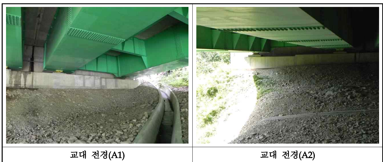
【사진 3.3.8】 교대 전경(부산)
